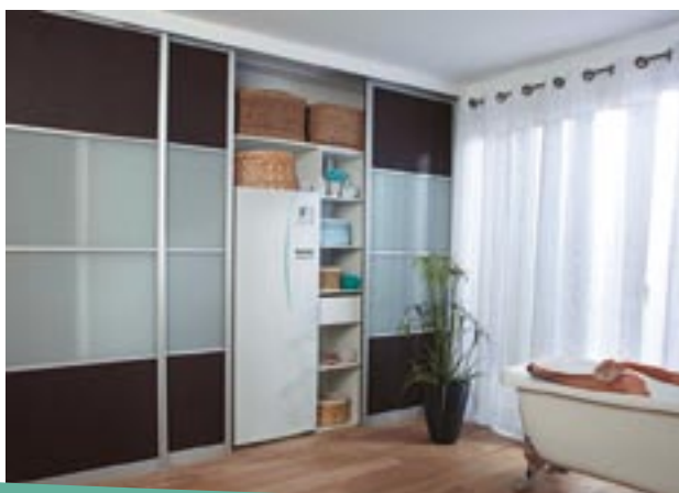
Primer montaže vodne enote R.S.T.V. v bivalnem prostoru.
